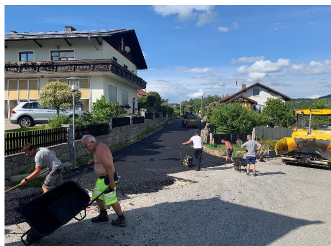
Asphaltierungsarbeiten beim Lindenweg
